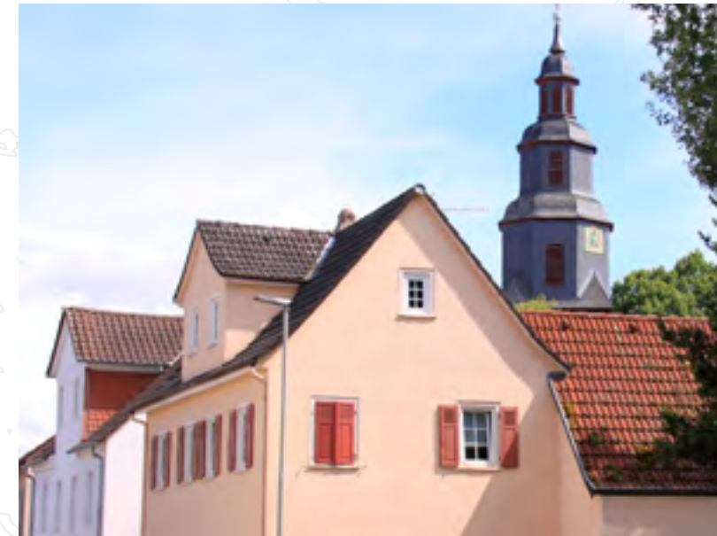
Typisch für die Dachgestaltung innerhalb des Fördergebietes sind schlank gestaltete Dachränder und geringe Dachüberstände an Ortgang und Traufe
