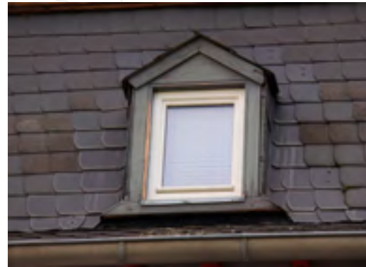
Giebelgaube in einem Mansarddach
