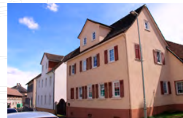
Traufständige Gebäude mit Zwerchhaus
