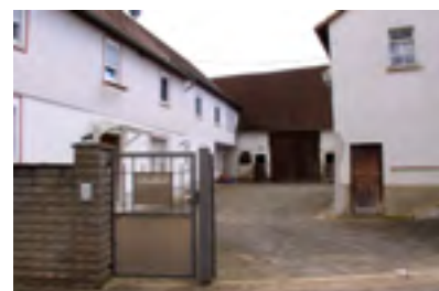
Hofraum hinter der Großen Burggasse 5
