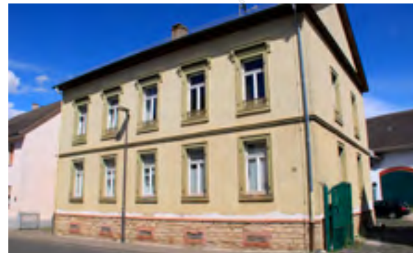
Ein historisches Gebäude mit vielen Gliederungselementen. Die Scharniere für die Klappläden sind noch vorhanden. Die Läden selber wurden entfernt.
