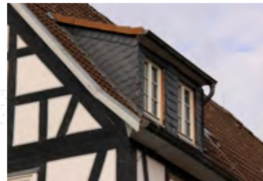
Gut in die Dachfläche integrierte Schleppgaube
