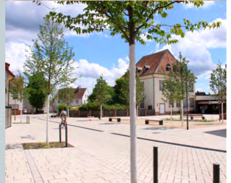
Eingebaute Versickerungsrinne (Bürgerhausvorplatz Rodgau-Dudenhofen)
