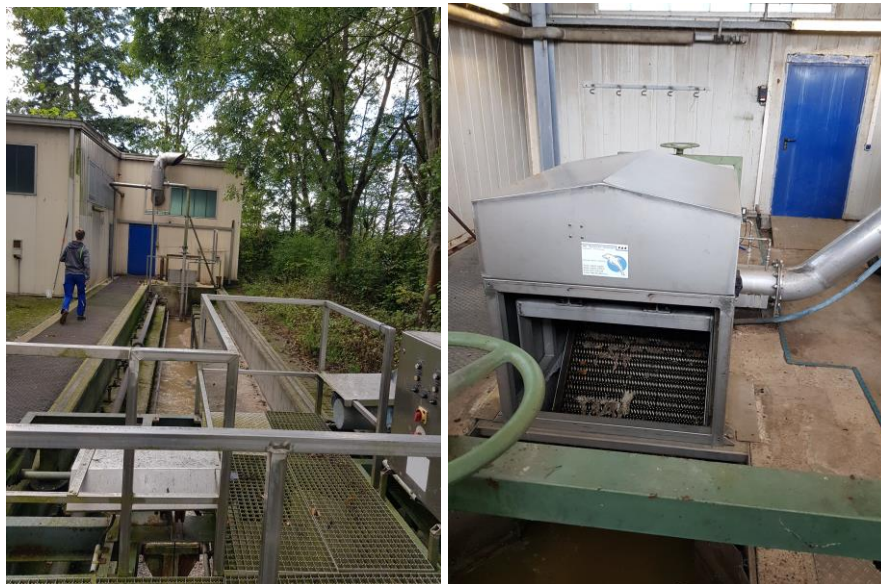
Abbildung 3-1: Blick auf Sandfang (links) und Rechen (rechts)
