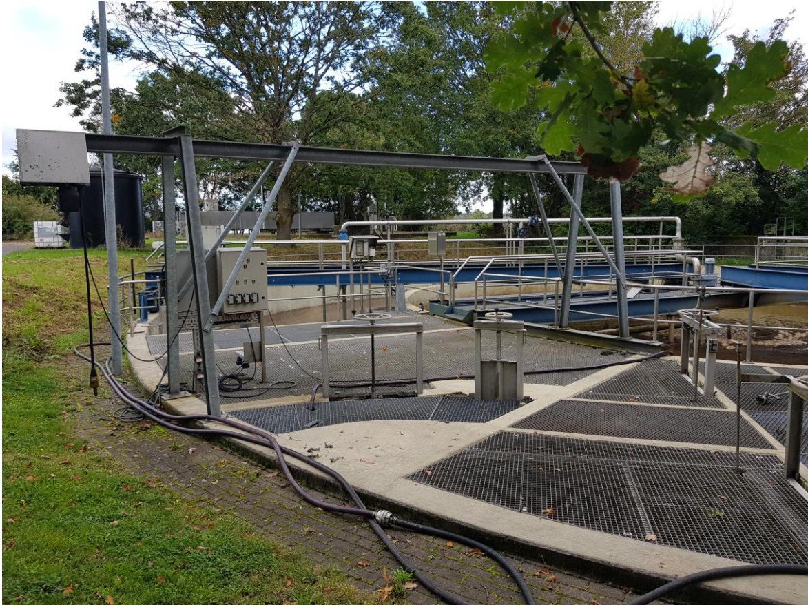
Abbildung 3-2: Blick auf die Vorklärung mit Denitrifikationsbecken
